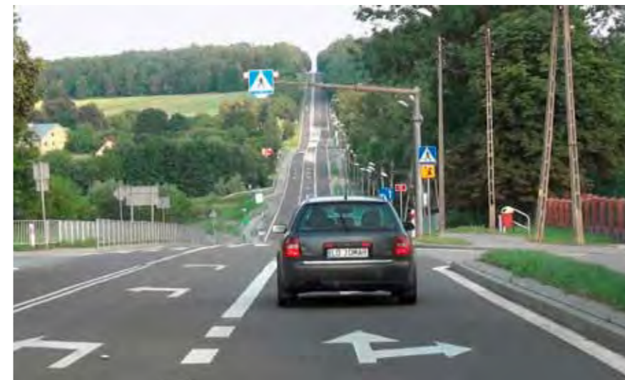
Местные и региональные дороги имеют ровное покрытие, разметку, систему отвода осадков, освещение на опасных участках, приспособления для принудительного снижения скорости движения и т.д.
