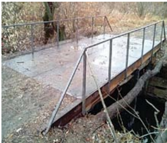
Каменский р-н, Верхнемарковское сп, ТОС «Верхнемарковский» – ремонт моста
