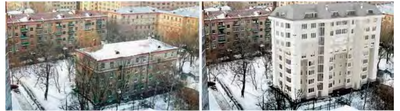
Жилой дом до реконструкции
