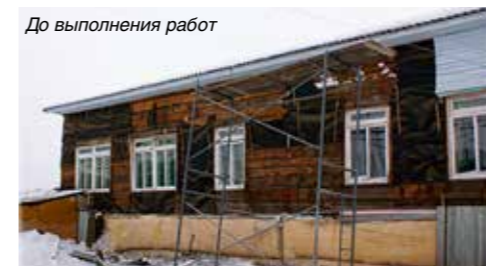
До выполнения работ
