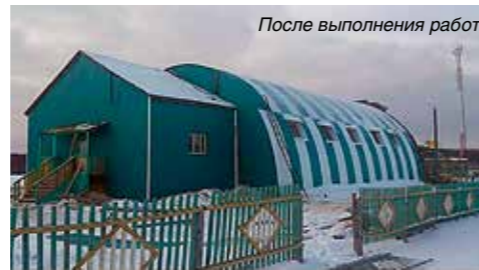
Утепление пенополиуретаном и обшивка фасада здания спортзала п. Дююсы
